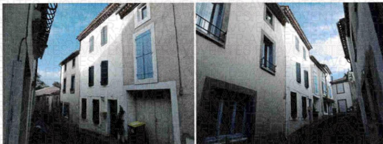
La façade côté Nord est une façade en plusieurs parties où nous avons plusieurs pièces et décrochements. Cette façade est en crépi lissé. Il existe des chéneaux de récupération des eaux pluviales. A l'extrémité du toit, il existe un pigeonnier (photos n° 3 et 4).
