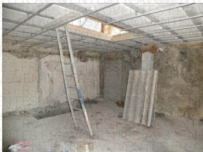
Une échelle donne accès au deuxième étage : sol en chape béton, murs bruts, plafond en plaques avec chevrons. Une extension a été effectuée en brique non crépi (photos n° 11 à 14).
